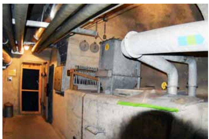
Atom-Partikelfilter im Gang zum Notausstieg.
