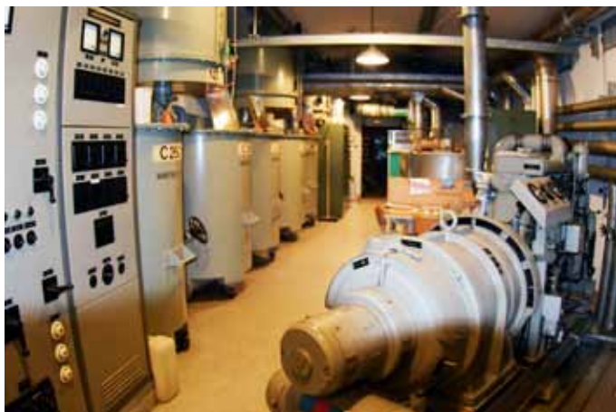
Maschinenraum mit Verteil- und Steuertableau, Dieselmotoren und Kampfstofffilter.
