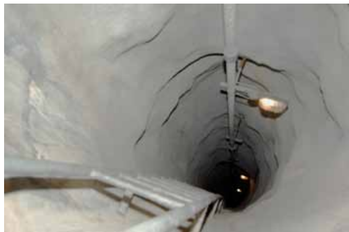
Blick in die Tiefe des Notausstiegsschachtes. An der hinteren Schachtwand Auspuffrohr der Dieselmotoren.
