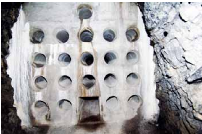
Geschützte Frischluftansaugstelle.
