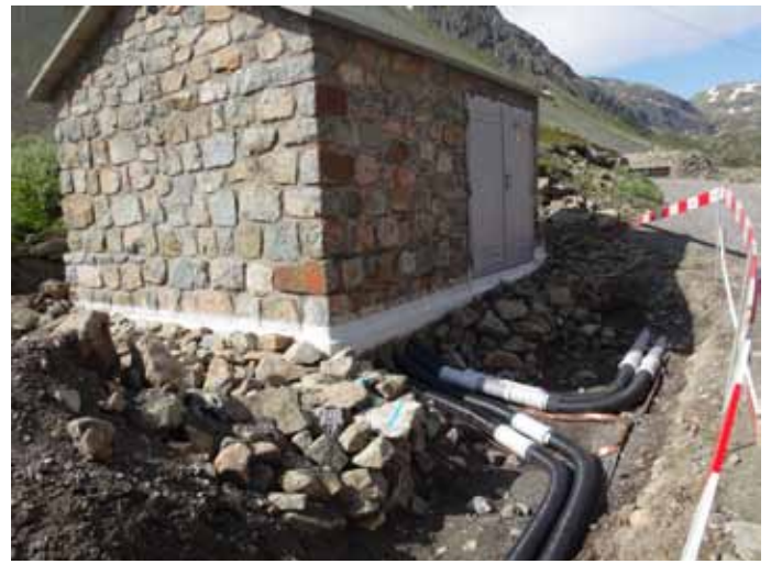
Das alte Tankbarrikadenmagazin wird in eine Trafostation umgebaut.
