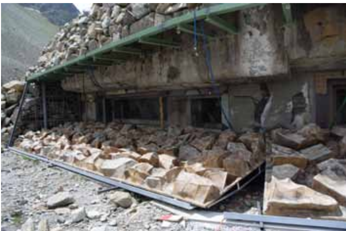
Die restaurierten Tarnungstore sind wieder an ihrem Origanlastandort.
