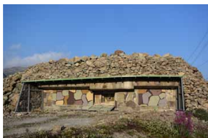
Bis auf die Bemalung der Betonflächen ist die Scharfront restauriert.
