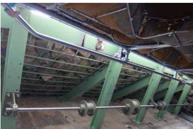
Die Rollen und Züge für das Senken und Heben der Tarnungstore werden installiert und die Seile angepasst.
