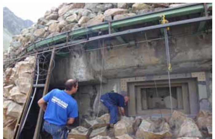
Die Rollen und Züge für das Senken und Heben der Tarnungstore werden installiert und die Seile angepasst.
