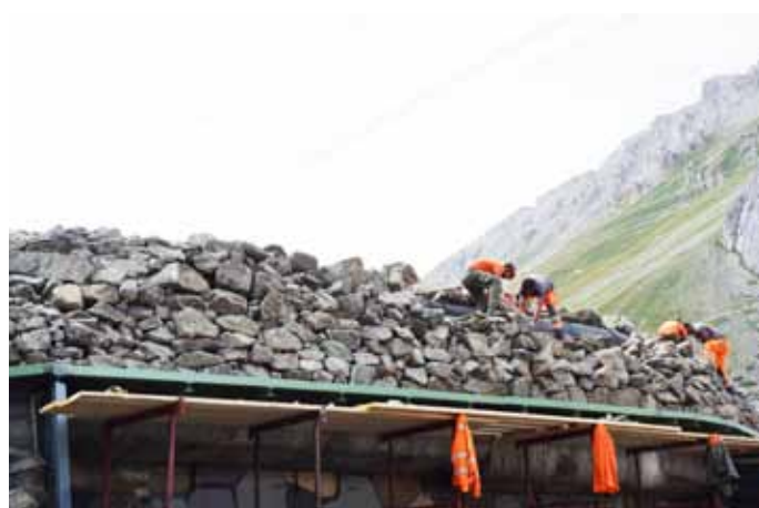
Die Bruchsteinvormauerung des Bunkerdaches wird von Maurern der Baufirma Broggi Lenatti und von Rekruten des Zivilschutzes neu erstellt. Es ist schwierig, nicht eine schöne sondern eine möglichst wilde Vormauerung zu bauen.
