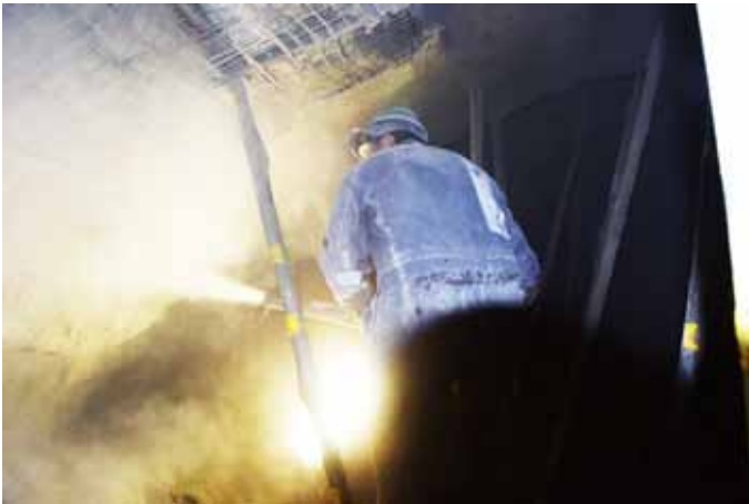
Eine ca. 5 cm dicke Spritzbetonschicht wird von unten aufgetragen. So kann die alte Tarnung nachhaltig stabilisiert werden.
