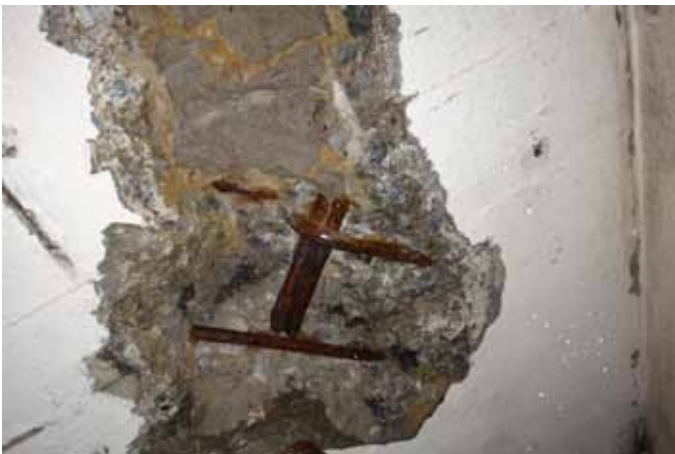
Durch das undichte Bunkerdach ist Wasser in den Bunkerbeton eingedrungen. Dieser hat sich fast wie ein Schwamm mit Wasser vollgesaugt. Ueber 300 Betonabplatzungen auf den drei Stockwerken sind die Folge.
