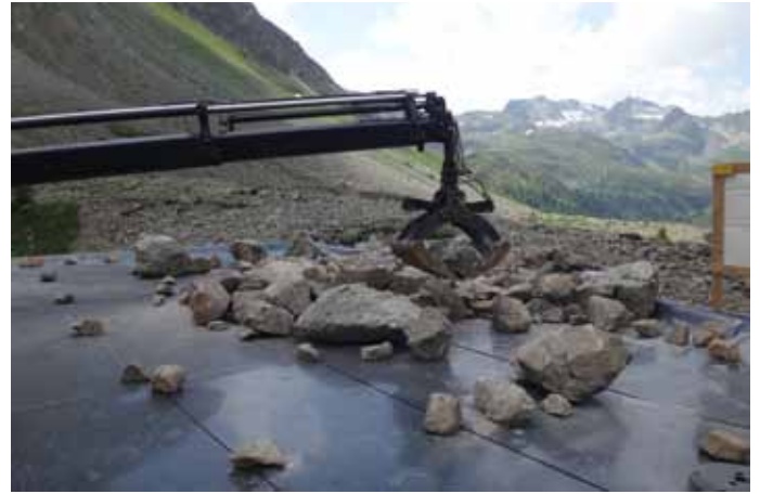
Die Abdichtung wird vor dem Wiedereindecken mit Kunststoffmatten vor Beschädigungen geschützt.
