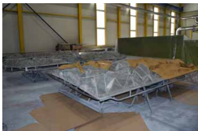
Das Drahtgeflecht wird mit einer Spachtelmassen in der Farbe des Grundtones bestrichen.
