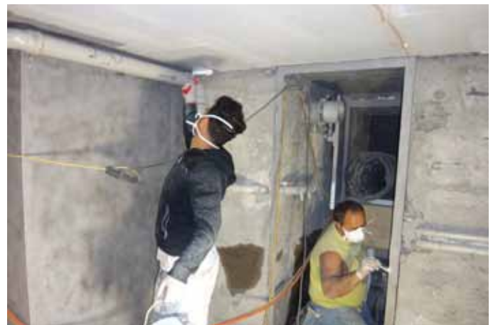
Der Beton wird mit Spezialmörtel reprofiliert und das ganze Bunkerinnere wird neu gestrichen.
