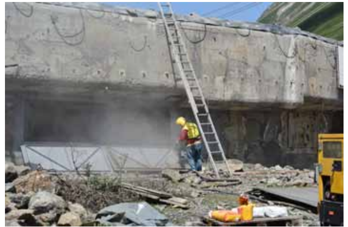
Die verrosteten Scharntore werden sandgestrahlt.
