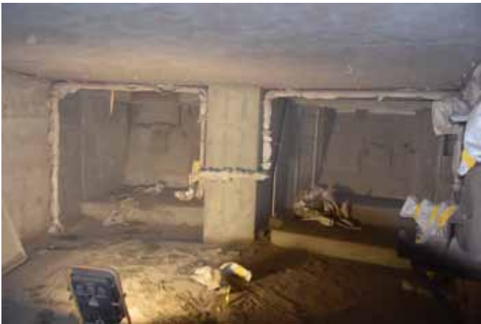
Wände und Decken werden sandgestrahlt.
