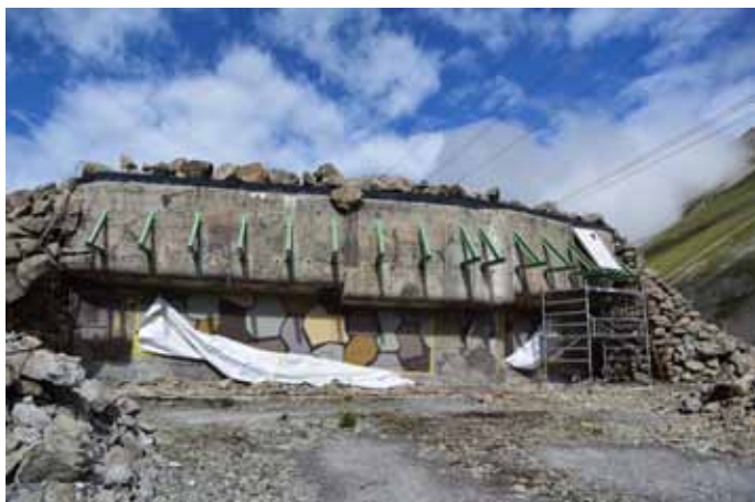
Die neue Stahl-Tragkonstruktion wird montiert...
