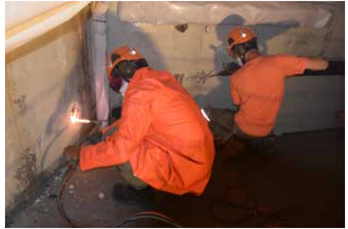
Die Betonabplatzungen werden freigespitzt und die rostigen Armierungseisenstücke herausgetrennt.
