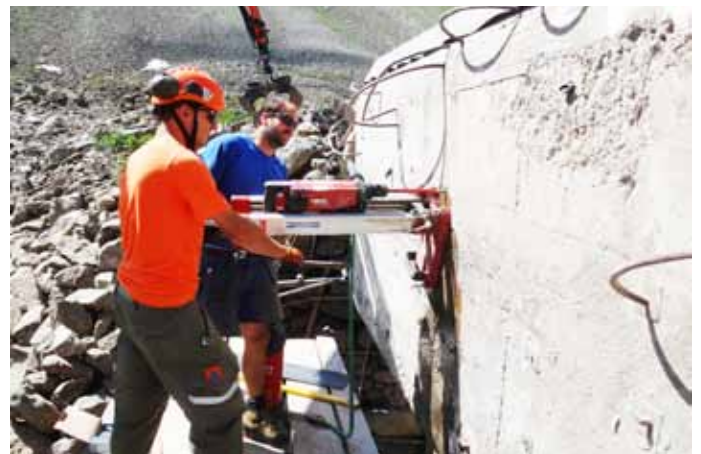
Ueber 100 Ankerlöcher werden für die Montage der neuen Stahlkonstruktion ins Bunkerdach gebohrt. Es gab keine Bohrung, bei der nicht wenigstens ein Armierungseisen durchbohrt werden musste.
