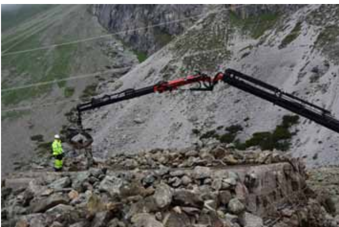
Etwa 400 Tonnen Albulagrinitblöcke werden vom stark undichten Bunkerdach entfernt.
