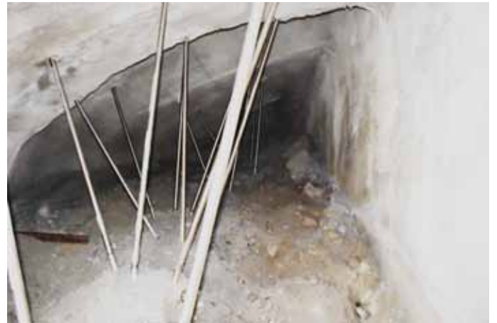
Eine ca. 5 cm dicke Spritzbetonschicht wird von unten aufgetragen. So kann die alte Tarnung nachhaltig stabilisiert werden.
