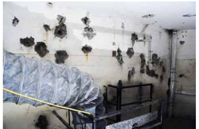
Durch das undichte Bunkerdach ist Wasser in den Bunkerbeton eingedrungen. Dieser hat sich fast wie ein Schwamm mit Wasser vollgesaugt. Ueber 300 Betonabplatzungen auf den drei Stockwerken sind die Folge.
