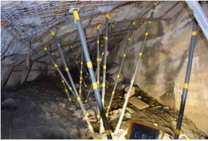
Unter dem bestehenden Spritzbeton wird in einem Abstand von ca. 3 cm ein zusätzliches Netz fixiert.
