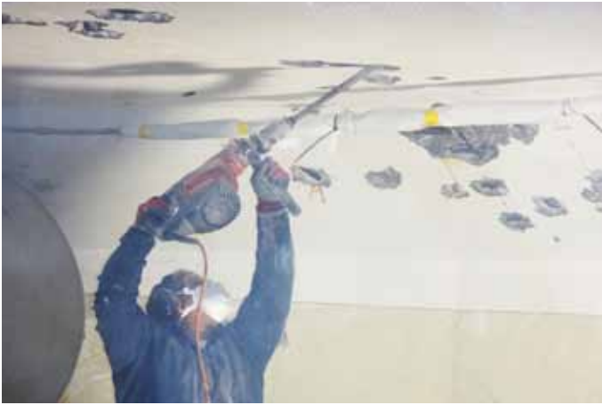
Die Betonabplatzungen werden freigespitzt und die rostigen Armierungseisenstücke herausgetrennt.
