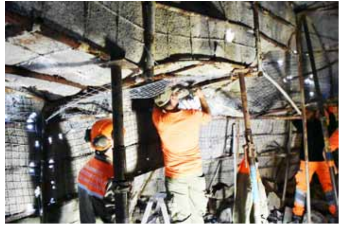
Unter dem bestehenden Spritzbeton wird in einem Abstand von ca. 3 cm ein zusätzliches Netz fixiert.
