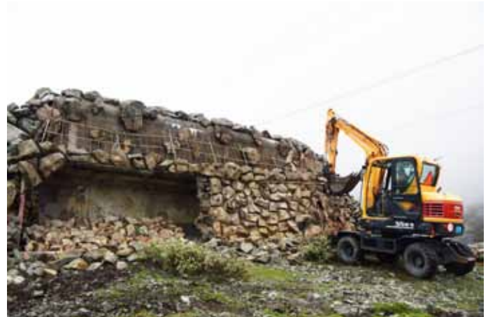
Schwierige Demontage der alten Scharntentarnungstore. Der Druck auf der gesamten Konstruktion ist gefährlich gross.
