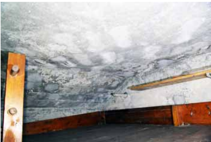
Der Beton wird mit Spezialmörtel reprofiliert und das ganze Bunkerinnere wird neu gestrichen.
