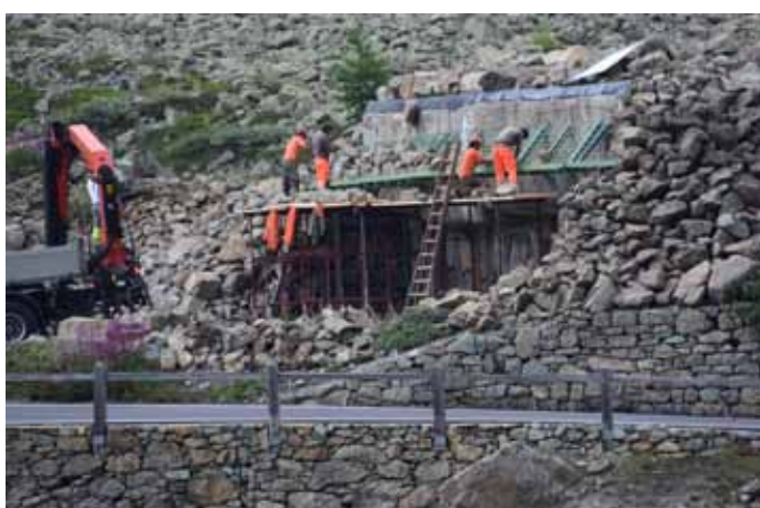
Die Bruchsteinvormauerung des Bunkerdaches wird von Maurern der Baufirma Broggi Lenatti und von Rekruten des Zivilschutzes neu erstellt. Es ist schwierig, nicht eine schöne sondern eine möglichst wilde Vormauerung zu bauen.
