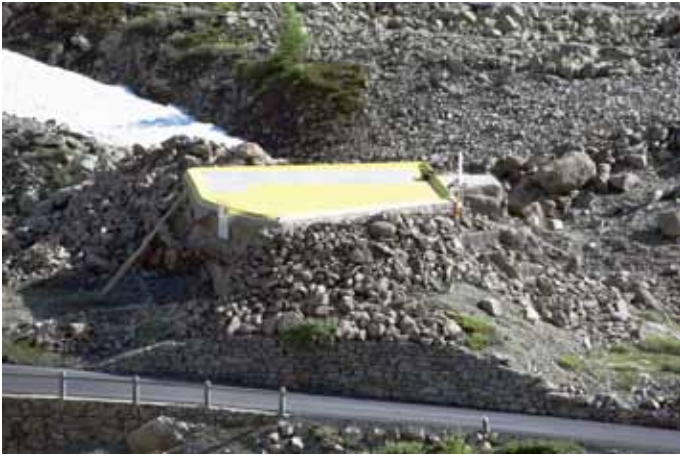
Das Bunkerdach wird mit Abdichtungsfolien belegt und verschweisst, die normalerweise zur Wasserverdrängung im Stollenbau eingesetzt werden.
